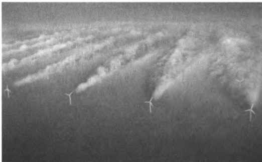
Abb. 14: Windräder bremsen den Wind und führen zu Turbulenzen wie hier im Windpark Horns Rev 1 in Dänemark.
